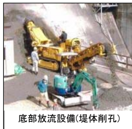
底部放流設備設置工事
