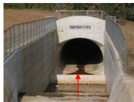
放水トンネル(H18.12完成)
