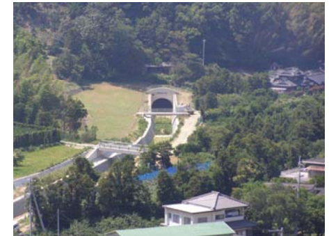
放水トンネル(H21.6撮影)
