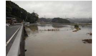
平成20年6月29日梅雨前線豪雨 福井川流域の冠水状況
