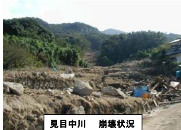
見目中川 崩壊状況
