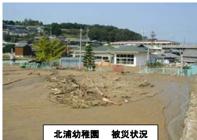
北浦幼稚園 被災状況
