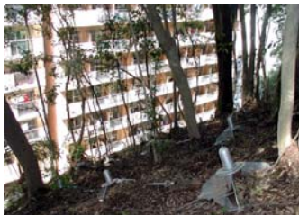
地山補強土工法
