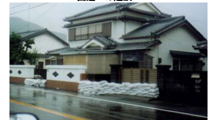
越波対策で土嚢を設置
