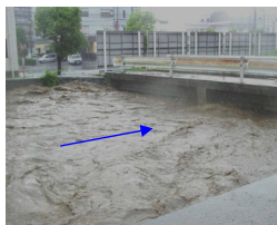
庄内西橋 新居浜市高木町（H16.9）
