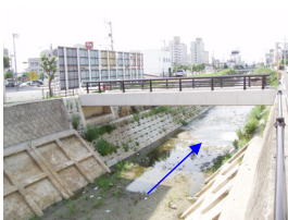
庄内西橋 新居浜市高木町（H20.6）
