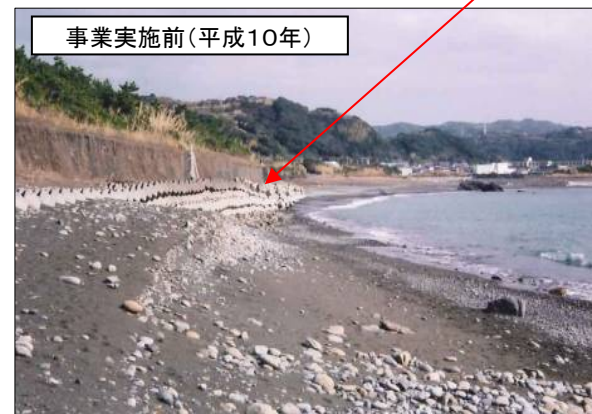
人工リーフ設置前(平成10年)と比べ、整備後は、背後の砂浜について、回復が見られる
