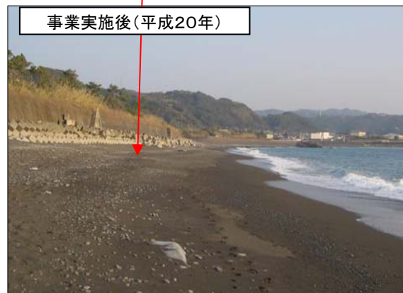
人工リーフ設置前(平成10年)と比べ、整備後は、背後の砂浜について、回復が見られる
