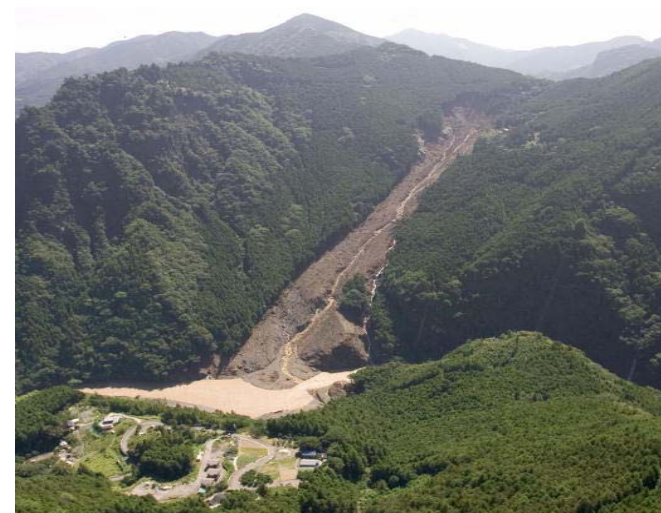
【山腹崩壊の被災状況】
