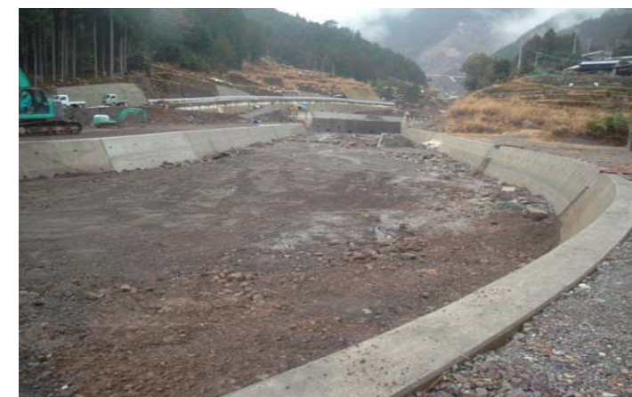
【被災河川の復旧状況】
