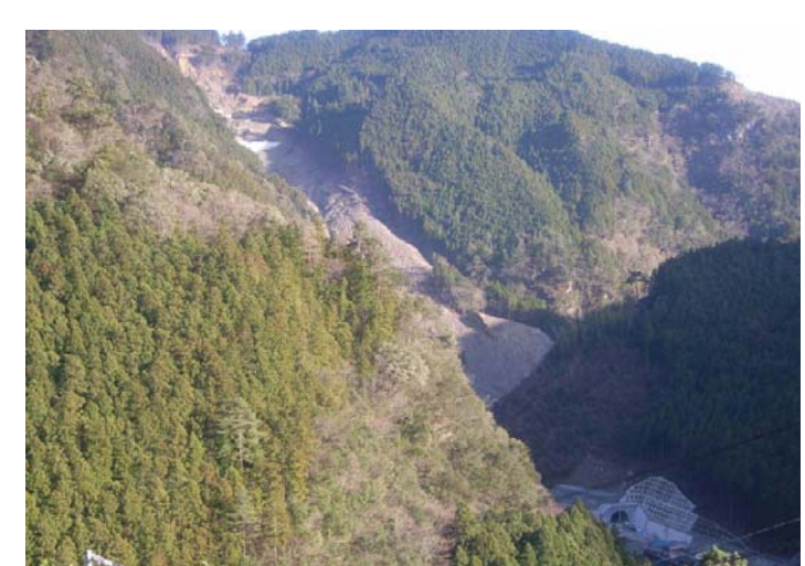
【山腹復旧状況】
