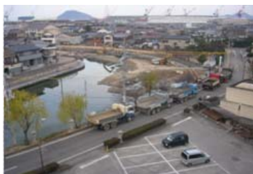
現在の施工状況
