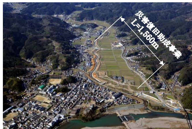
進捗状況(平成 20 年 2 月)
