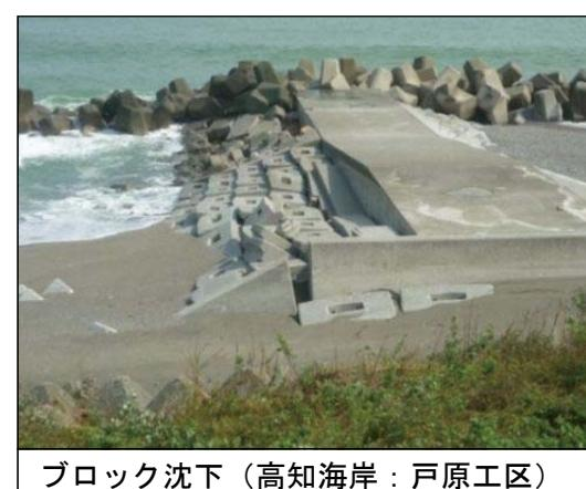
ブロック沈下 (高知海岸: 戸原工区)
