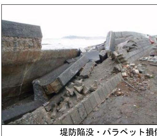
堤防陥没・パラペット損傷 (高知海岸: 南国工区)
