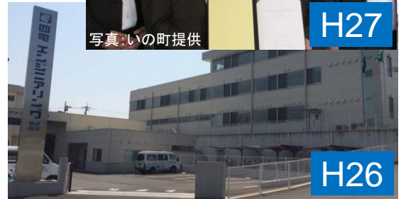
災害時に頼りになる電気設備会社の進出 発電施設・通信網の早期復旧が可能(H26.7移転)
