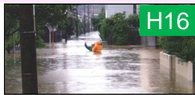
浸水被害の状況 (H16.8)
