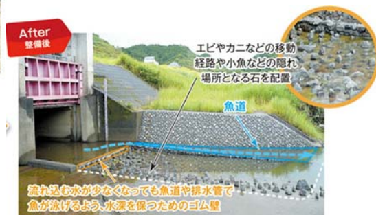
河川の連続性の確保の実施状況(九樹樋門)
