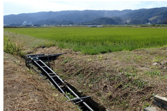
水田魚道の設置
