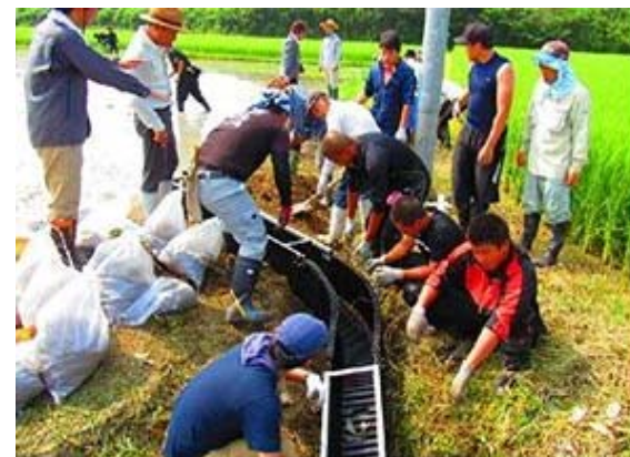
休耕地ビオトープへの魚道の設置 出典：コウノトリ定着推進連絡協議会ウェブサイト
