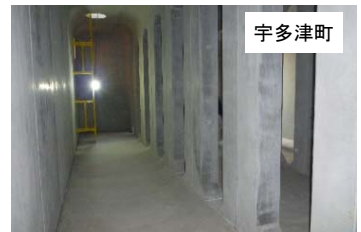
雨水貯留槽の内部状況
