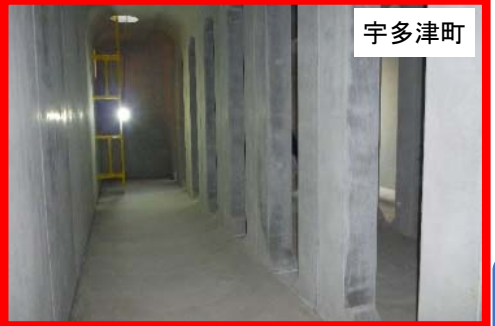
雨水貯留槽の内部状況
