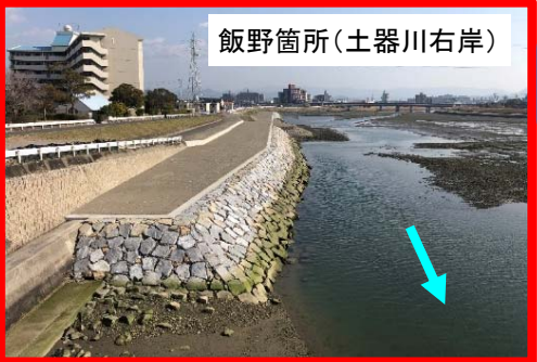
堤防整備状況
