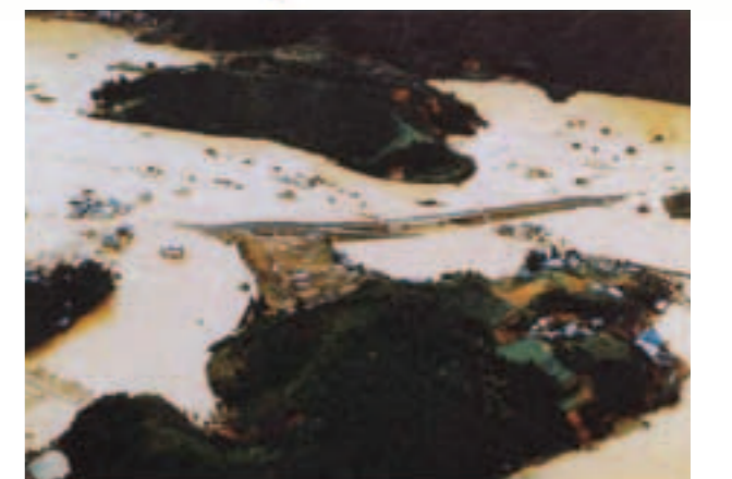
昭和50年8月洪水 JR岡花駅周辺浸水状況
