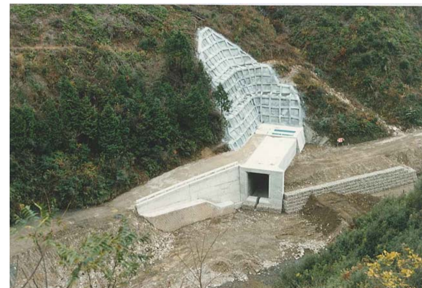
仮排水トンネル(他ダム事例)
