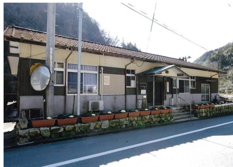
いわや 湛水区域内にある岩谷集会所
