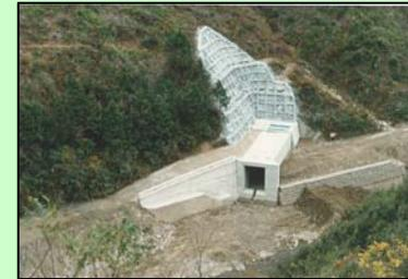
・ダムを築造するため、川の流れを一時的に切り替えるための工事(仮排水路トンネル)
