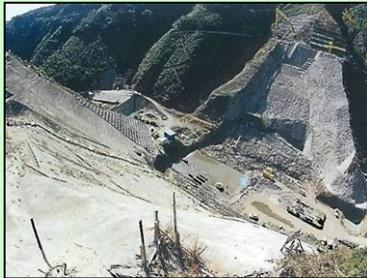
・堅固な岩盤にダムを築造するため、山の側面や川底を掘削する工事
