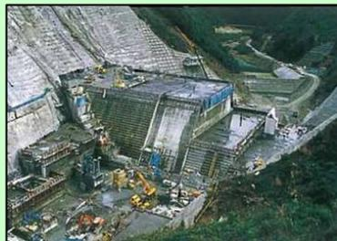
・コンクリートを所定の位置に流し込み、締固めなどを行い、ダムの形にする工事
