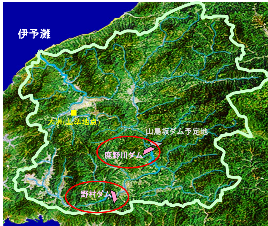
肱川流域のダム
