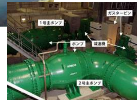
奥田川排水機場
