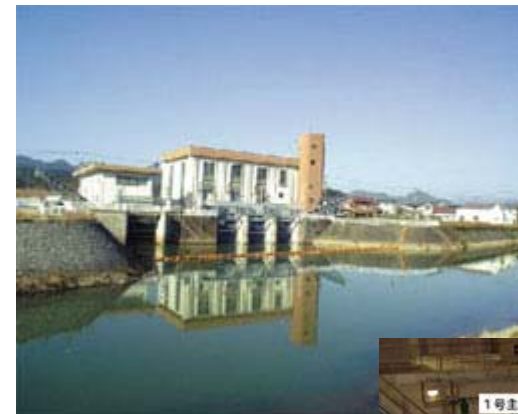
宇治川排水機場
