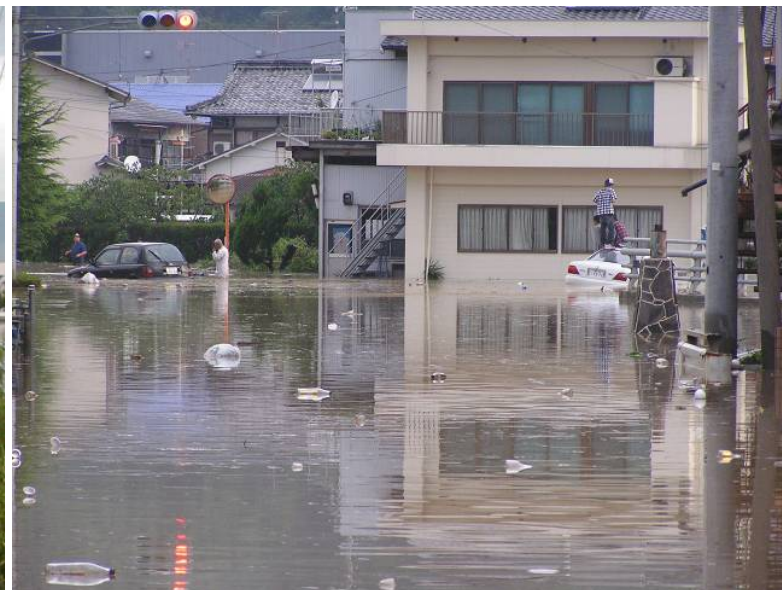
県道菅田五郎停車場線浸水状況
