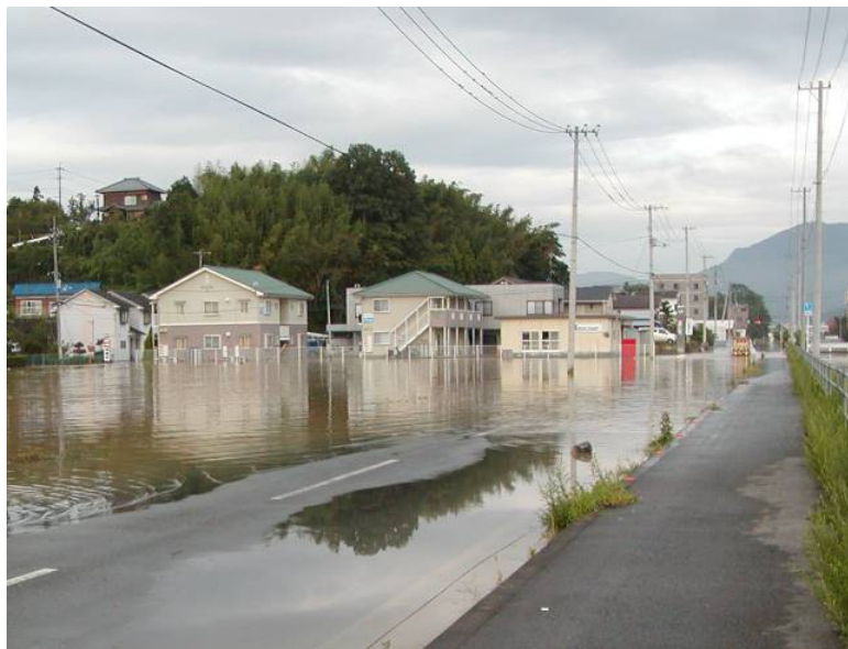
東大洲地区浸水状況
