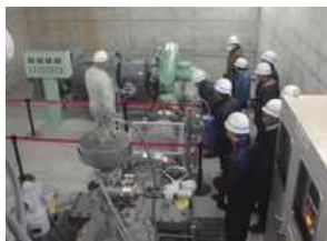
河川・ダム管理状況説明
