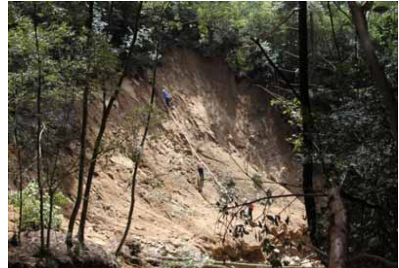
渓流点検調査（土砂崩落箇所）
