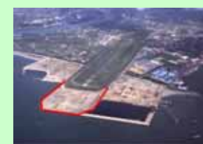
空港施設整備
