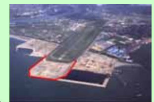
空港施設整備
