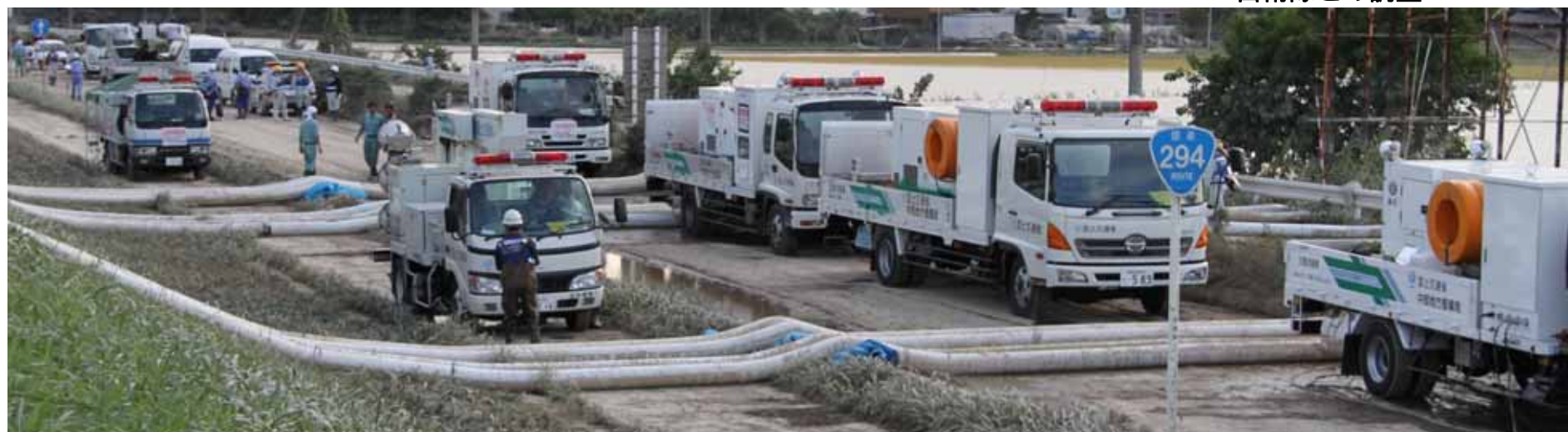
各整備局の排水ポンプ車による作業(四国地整、九州地整、中部地整)
