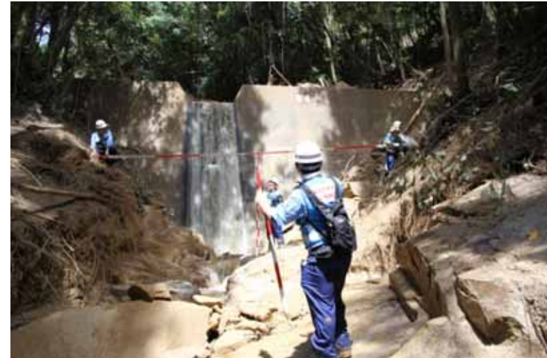
渓流点検調査
