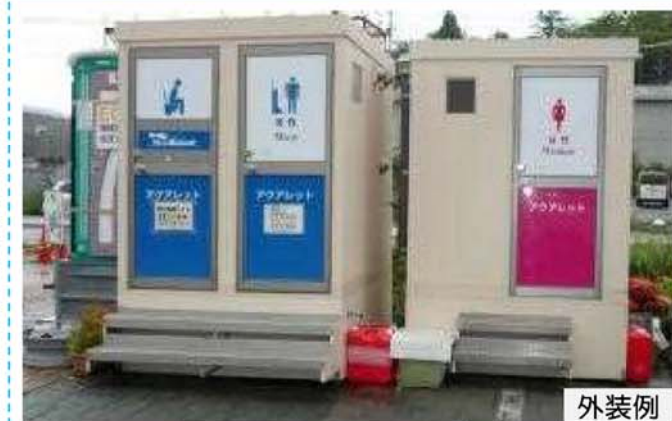
トイレ設置事例
