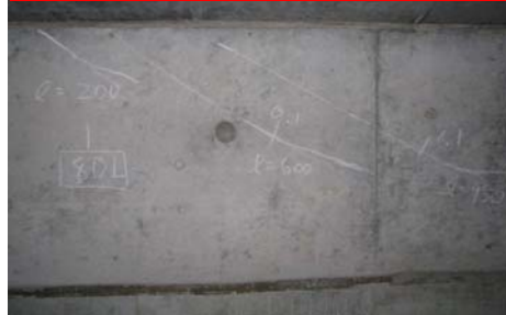
箱桁ウェブ面のひびわれ
