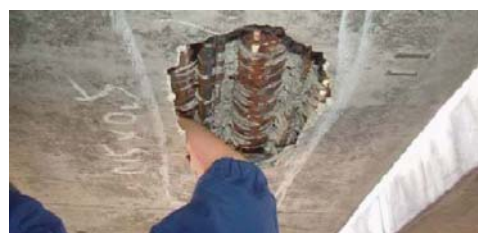
PCケーブル下面の空隙発見 (PCケーブルの腐食が要因)
