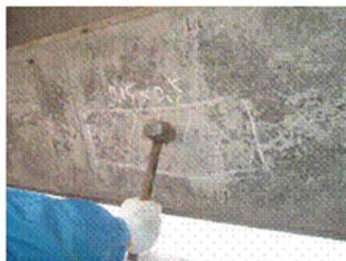
PCケーブル下面の空隙発見 (PCケーブルの腐食が要因)
