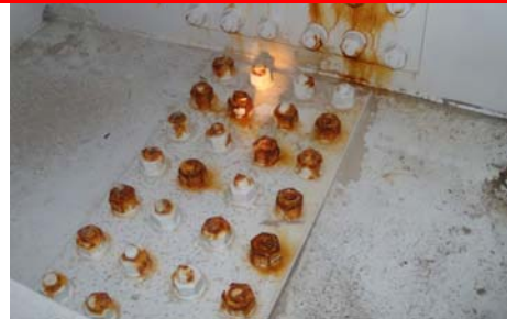
箱桁内主桁の防食機能の劣化
