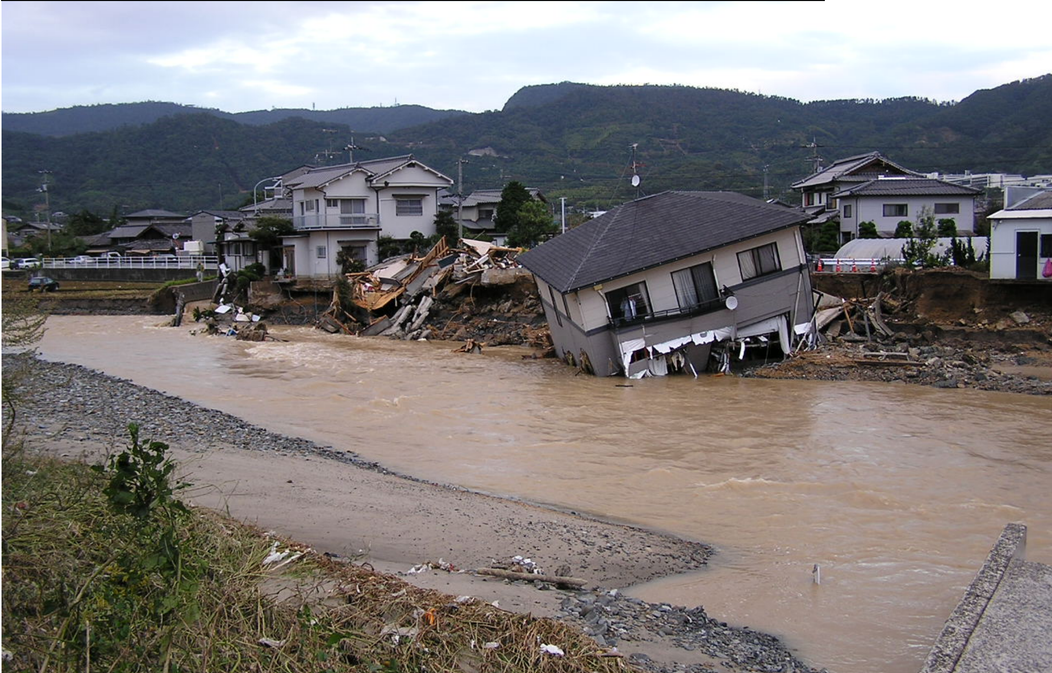
台風23号 堤防浸食（高松市：本津川左岸 H16）
