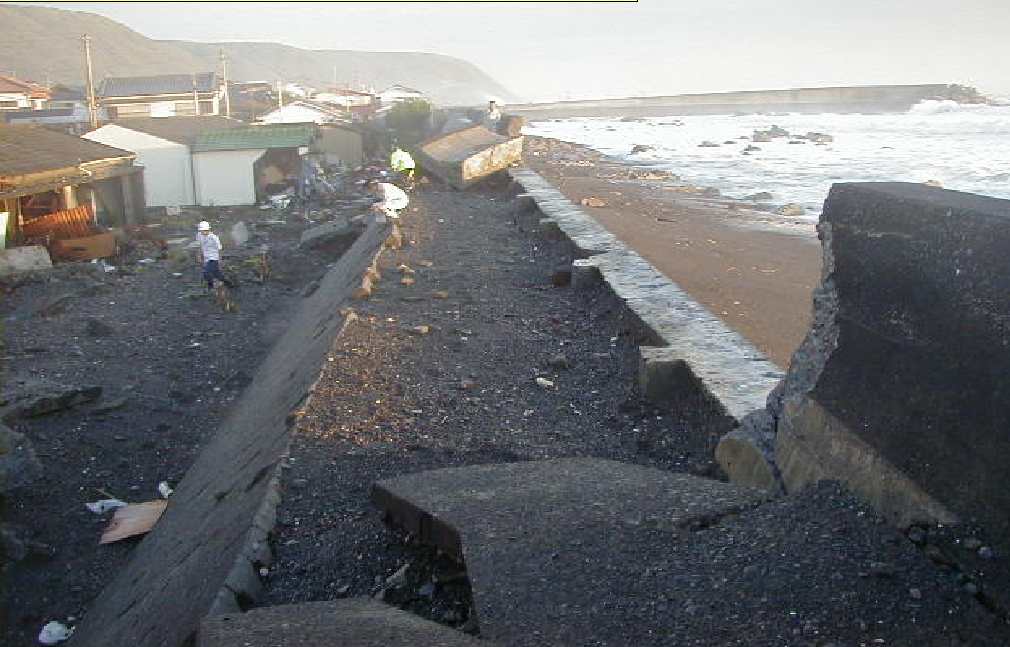
台風23号 海岸堤防倒壊（室戸市 H16）
