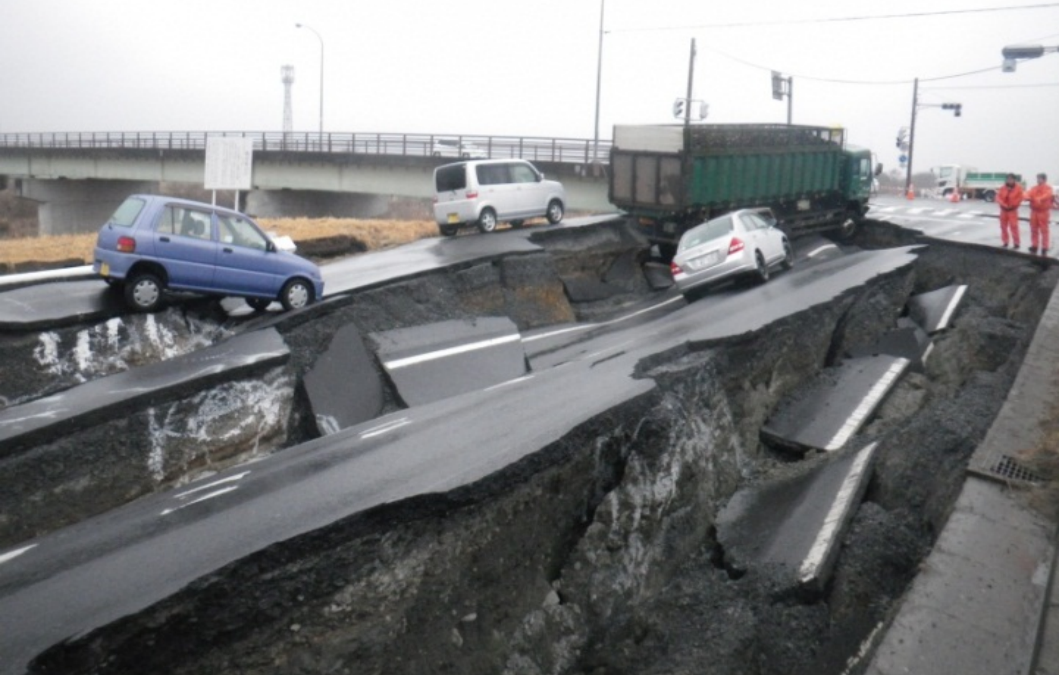
液状化により大破した北上川の堤防（東日本大震災）
