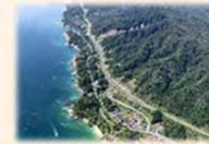
三陸沿岸道路（岩手県山田町）
