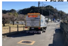
(空洞探査車による調査)
