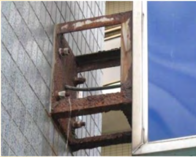
ブランケットの腐食による落下の危険のある看板 (国土交通省HPより)
