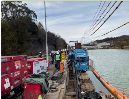
②電線近接の場合でも、継杭により上部障害対応可能
