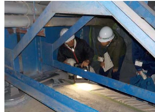
支承防錆工の施工状況見学
