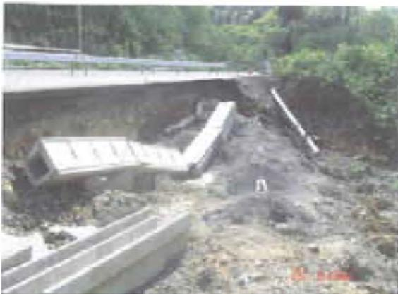
写真 盛土法面の崩壊状況
