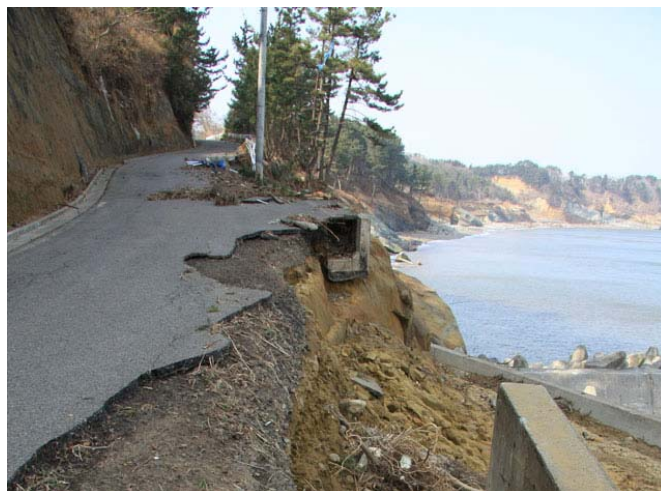
図 3-10 東日本大震災 盛土法面被害状況写真
