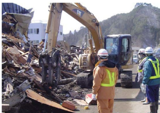
図 4-4 ガレキの撤去作業
