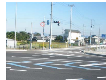
○従道路(県道)側への右折矢灯器の設置
