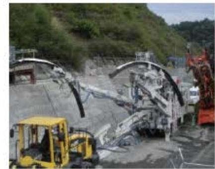
鋼製支保工をつかむ2本の腕と吹付けバウルを装備した機械。鋼製支保工建込みと吹付けコンクリート作業に使用し、素早く地山を固めます。
