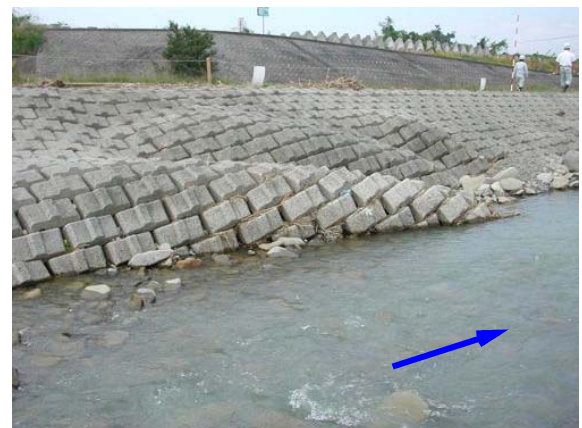
護岸被災状況 （土器川西側 河口より9.4k付近）
