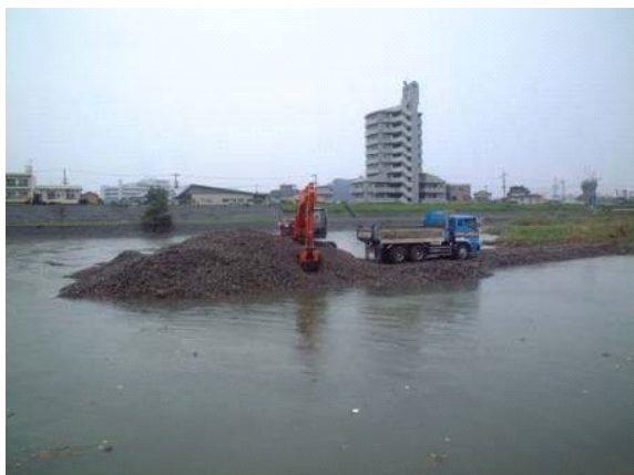
堆積土砂撤去状況 (土器川 河口より2.0km付近)
