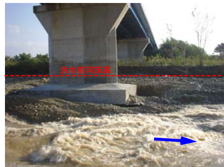
橋脚部の深掘れ状況(平成16年10月洪水) (土器川 河口より14.8km付近満濃大橋)
