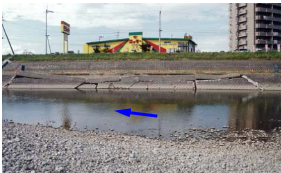
護岸崩壊状況(平成13年8月洪水) (土器川東側 河口より2.1km付近)
