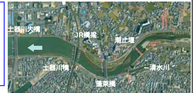
下流部の河道湾曲状況
