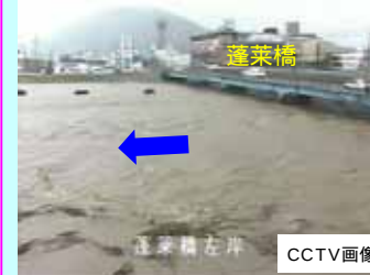
HWL相当まで水位上昇 （1.6k付近）
