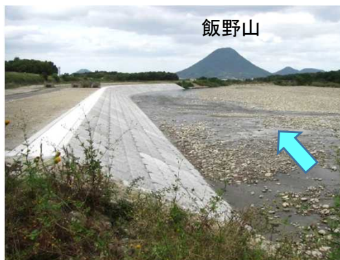
局所洗掘対策（垂水箇所）
