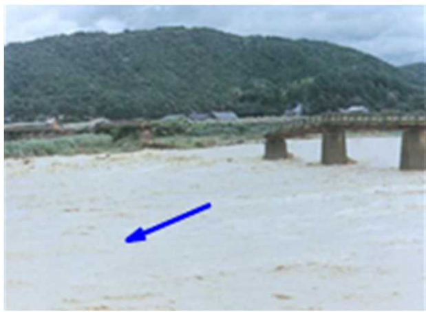
旧乙井橋流失(昭和50年8月洪水)
