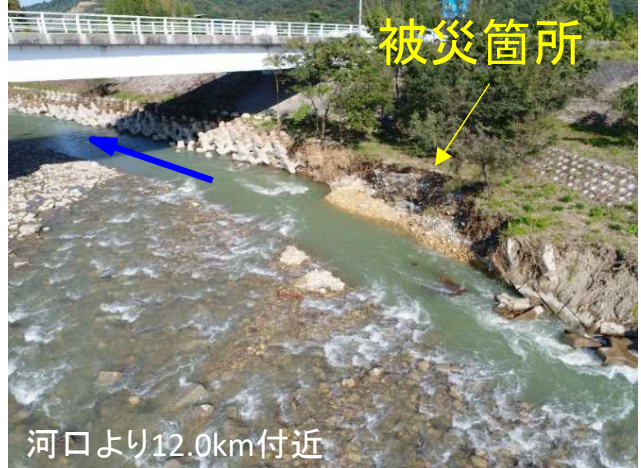
河岸侵食・根固め被災(平成29年9月洪水)
