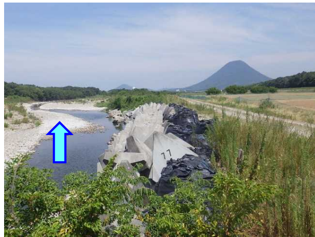
河岸護岸の被災状況（右岸9.2km付近）
