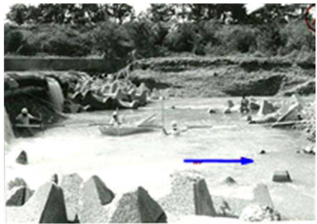
野津床止被災(平成2年9月洪水)
