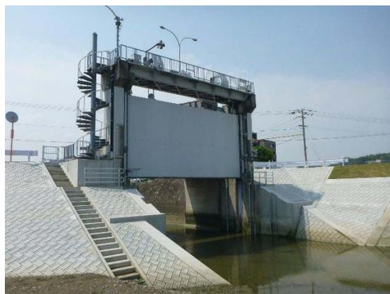
図 2.14 清水川水門の耐震補強対策
