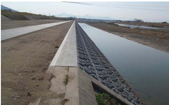
図 2.15 低水護岸整備（飯野箇所、右岸 4k/2 付近）
