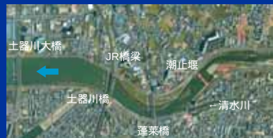
下流部の河道湾曲状況
