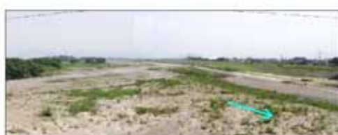
瀬切れ発生状況 (高柳橋上流:河口より6.0km付近)
