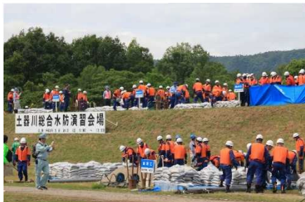
水防工法訓練(大型土のう工)
