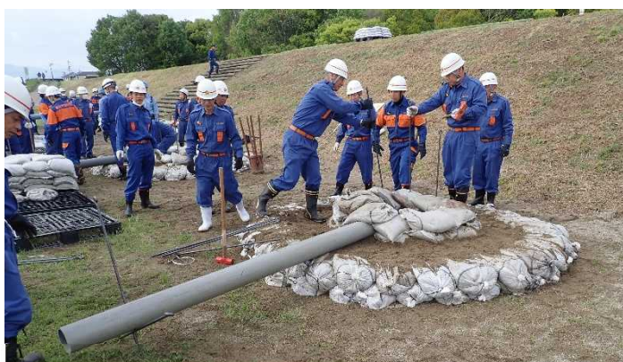
水防工法(釜段工)
