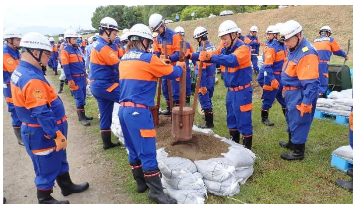
タコによる土の締固め
