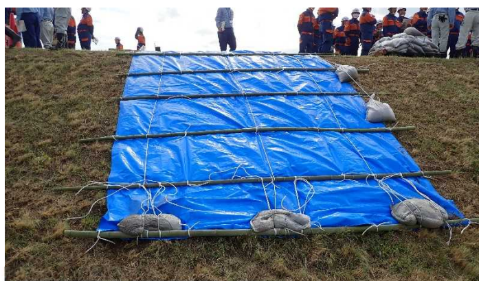
水防工法(シート張り工)
