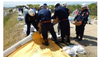
土器川水防技術講習会状況 水防工法(水防マット工)
