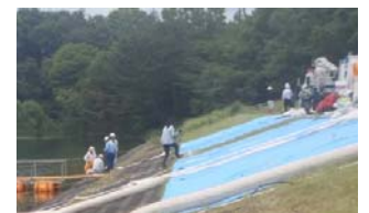
排水ポンプ車操作訓練状況 (排水ポンプホース設置)
