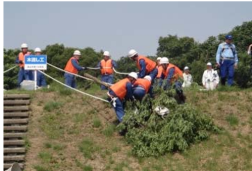
法崩れ対策工(木流し工、水防マット工)
