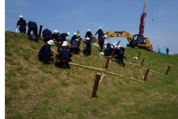
亀裂対策工(かご止め工)
