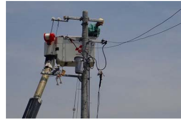
四国電力による配電線復旧訓練
