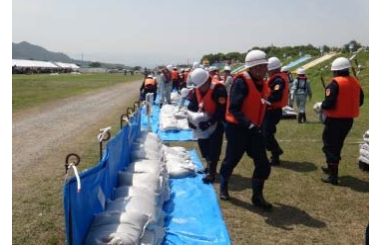
越水対策工(改良積土のう工)
