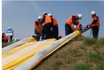
法崩れ対策工(木流し工、水防マット工)
