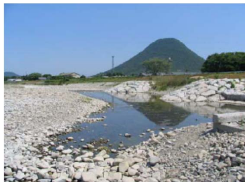
垂水地区水制工とたまり
