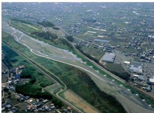
垂水地区水制工(河口より8.4km付近)
