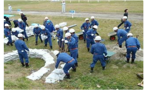
平成24年度水防演習(月の輪工法)
