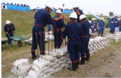
平成24年度水防演習(積み土のう工法)
