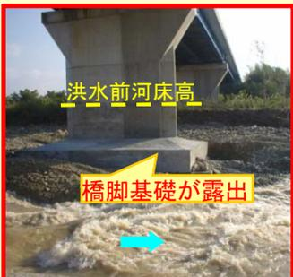
H16年の被災後に保護ブロックを設置→その下流側で河床低下が進行
