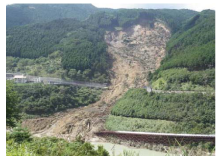
台風12号による被害状況
