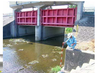
巡視点検状況
